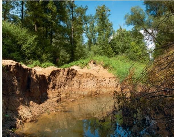
Abb. 2: Deichbruch am Vassenwall mit neu entstandenem Feuchtbiotop (August 2013)
