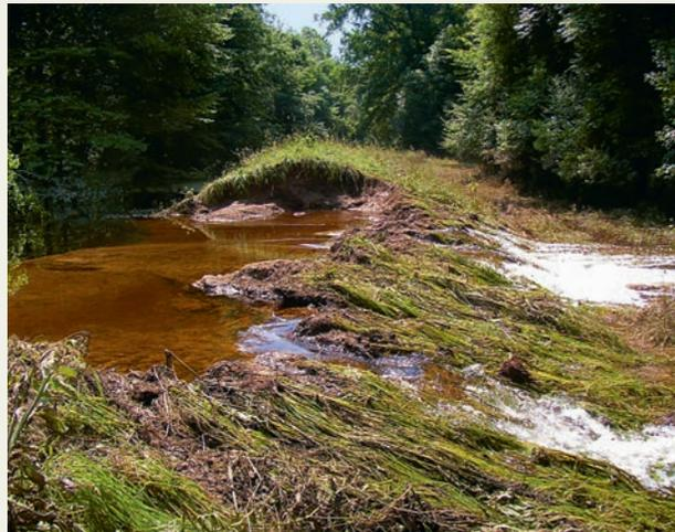
Abb. 3: Überströmung des Vassenwalls (Hochwasser, Juni 2013)
